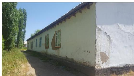
*Рис. 6 – Блоки школьных зданий со стенами из глинистых материалов, построенные без проекта и методом ашара, школа №78 им. З. Бакирова, Сузак*
