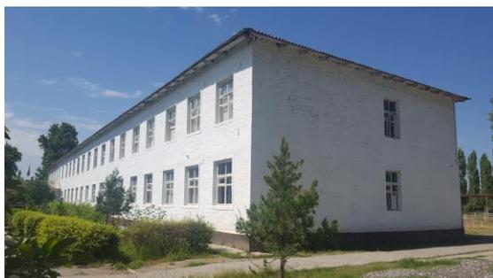
*Рис.5 – Здание школы со стенами из кирпичной кладки с железобетонными включениями, школа №20 им. М. Маткаримова, Сузак*
