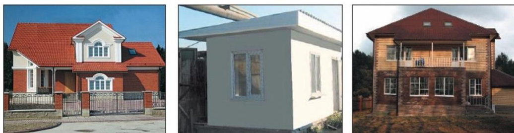
Рис. 3. Одноэтажные жилые здания. Наружные стены выполнены из гипсобетона
