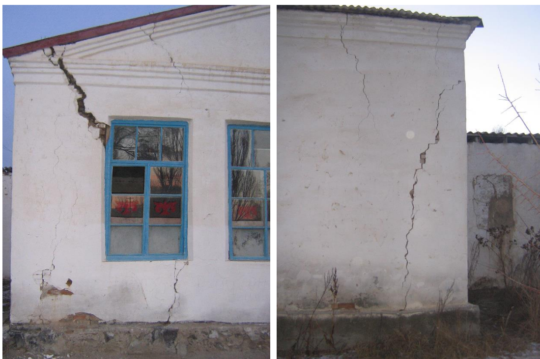
Рис.1. Кочкорское землетрясения 2007г, с. Кара-Тоо, здание сельского клуба
