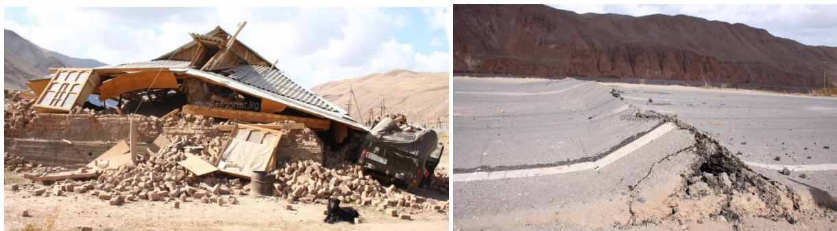
Рис.1. Состояние домов и дорог после землетрясения в с. Нура -2008 г.
