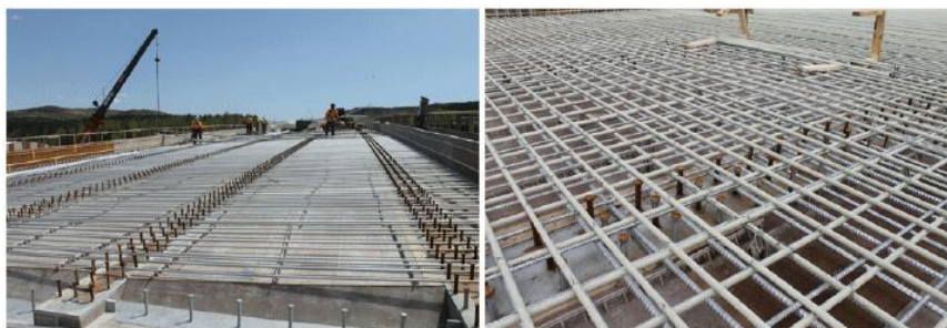
Фигура 4 – Строительство моста с применением стеклопластиковой арматуры (Квебек, Канада)
