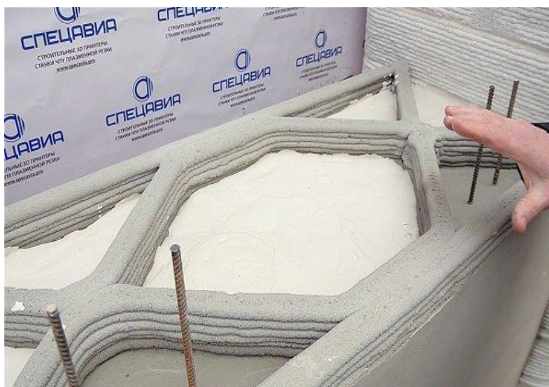
Фиг. 3. Конструкция стены, выполненная с помощью 3D-принтера согласно традиционной технологии.
