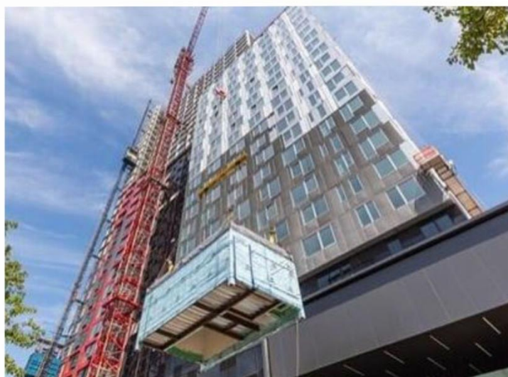
Рисунок 5 Строительство здания из модульно-блочных элементов со стальным каркасом, США [1]
