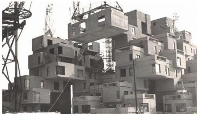
Рисунок 3 Монтаж элементов жилого комплекса «Habitat 67», Канада [1]
