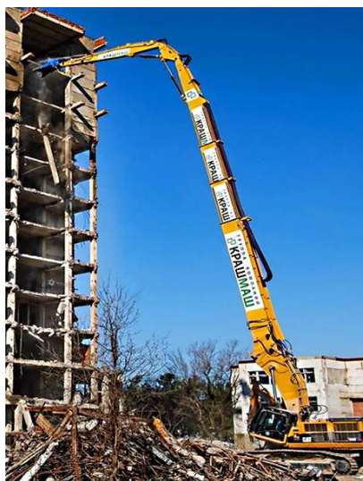
б) снос высотных зданий телескопической гидроножницей
