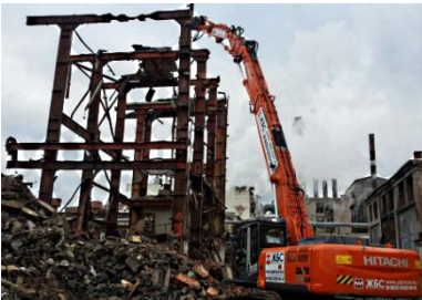
а) измельчение и снос металлоконструкций
