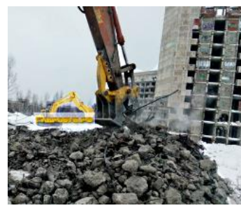
в) дробление гидножницей снесенных элементов
