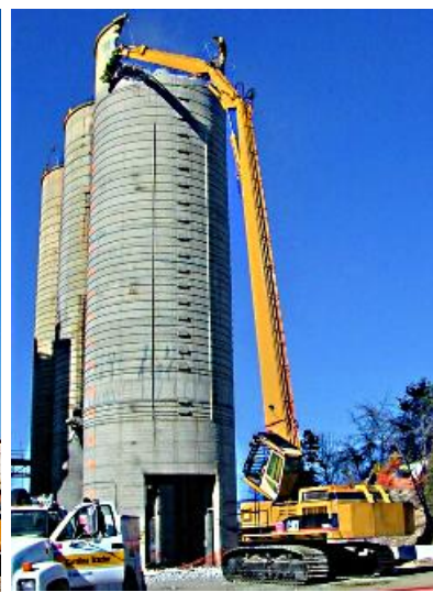
б) снос высоких сооружений гидроножницей
