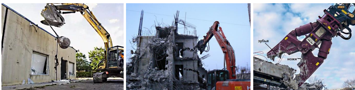
а) традиционная технология сноса «шар-молот»
