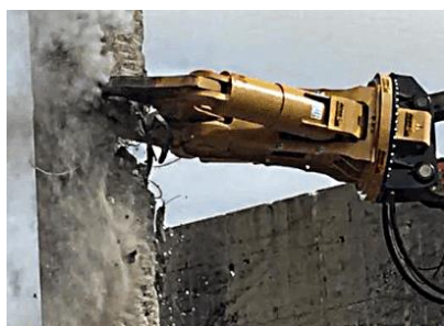
а) резание арматуры ж/б конструкции
