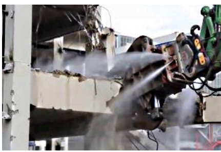
б) подавление пыли струей воды от системы гидножницы
