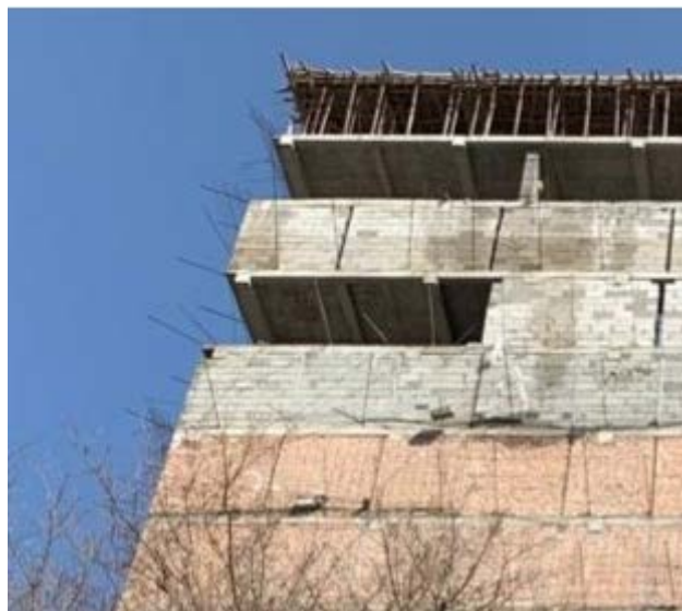
Рис.1. Обрушение ограждающей стены из пенобетонных блоков строящегося 15-этажного дома в г.Бишкек
