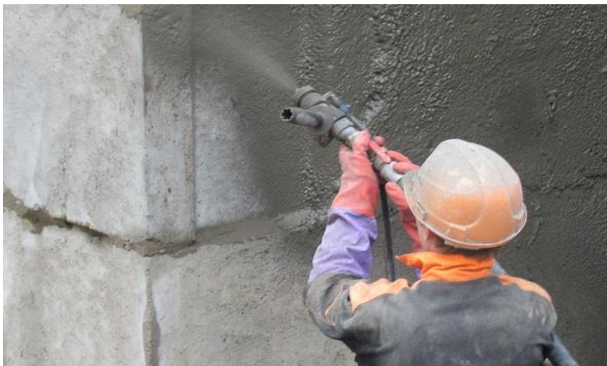
Рис-1. Защита конструкций из бетона влагоизоляционными средствами
