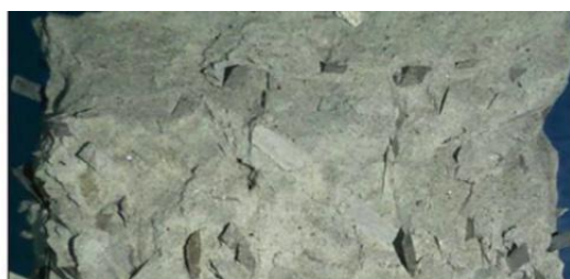
Рис. 3. Поверхность разрушенного фиброцементного образца, армированного аморфнометаллической фиброй
